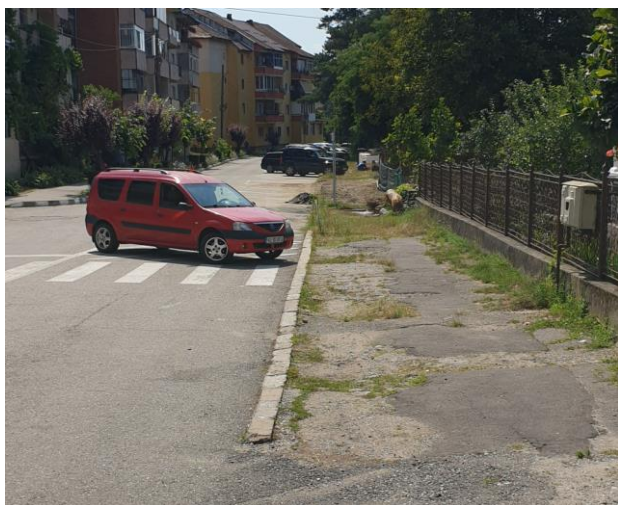
Figura 2.46. Trotuare cu grad ridicat de deteriorare/ lipsă (exemplificare).
