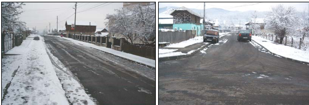
Străzile Zăvoiului și Vișinului, asfaltate în anul 2009 în localitatea componentă Gâtejești
